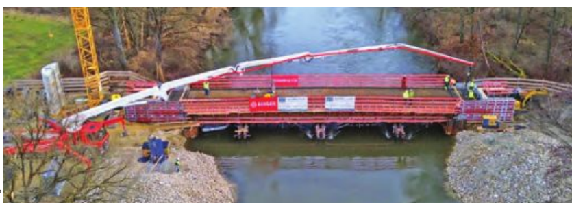
Neues Schalungssystem Formkit von Ringer: für kleinere und mittlere Brückenprojekte geeignet.
