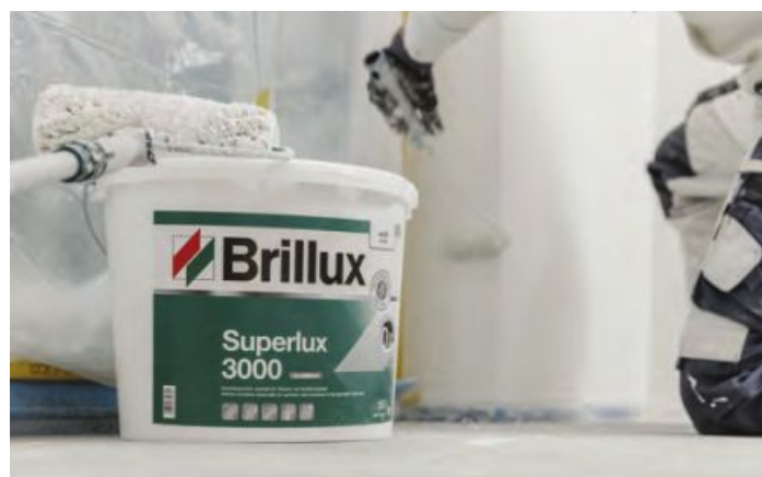
4. Schlussbeschichtung mit der stumpfmatte Innendispersion Superlux 3000.
