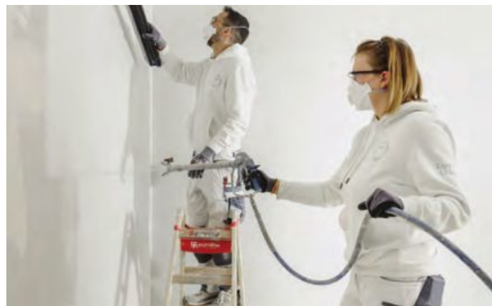
2. Spachtelung mit Spachtelmasse Briplast Powerfill 1891.
