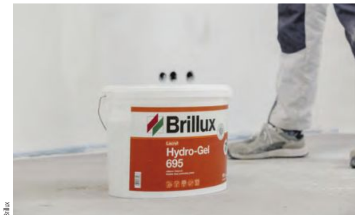
1. Grundierung mit Lacryl Hydro-Gel 695. Tropffreie Verarbeitung im Rollverfahren.
